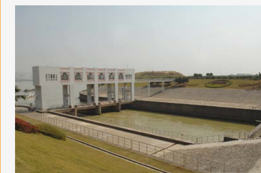
▲ 太園泵站取水口
