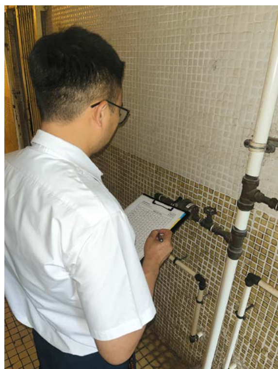
▲ 水喉匠檢視及記錄室外喉管物料和接駁方式是否符合標準
