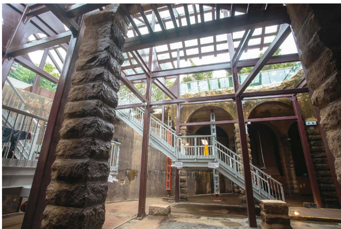
▲ 臨時加固和整理工程採用玻璃上蓋作天然採光
