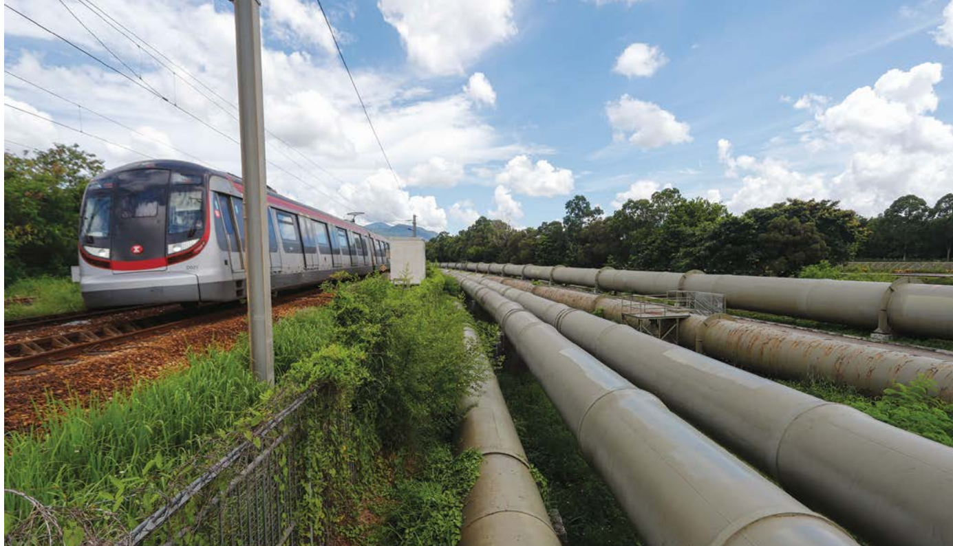
▲ 原水從木湖原水抽水站，經輸水管輸送至濾水廠作處理。這些水管直徑逾兩米，是水務署少數外露於地面的水管。
