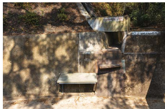
▲ 在引水道的石牆加建梯級，方便意外墮入引水道的動物自行脫險。
