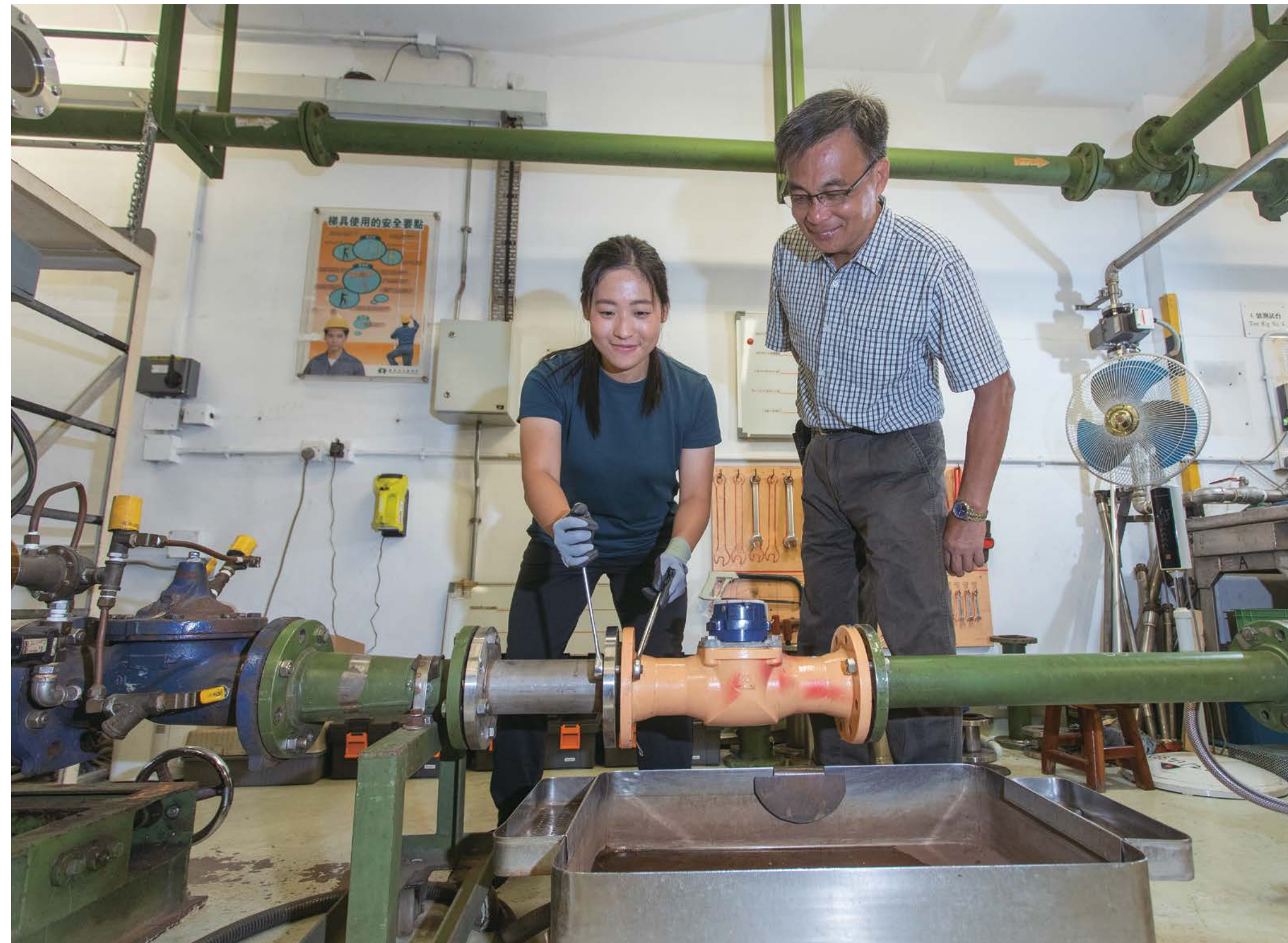
▲ 總水務督察祁德新（右）指導水務署學徒計劃畢業的高福儀（左）有關安拆大型水錶時所使用工具的知識及安全姿勢
