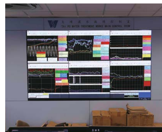
▲ 控制室牆上的屏幕展示各工序的實時水質指數
