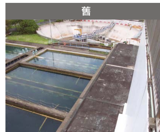
▲ [舊] 快速重力濾水池
