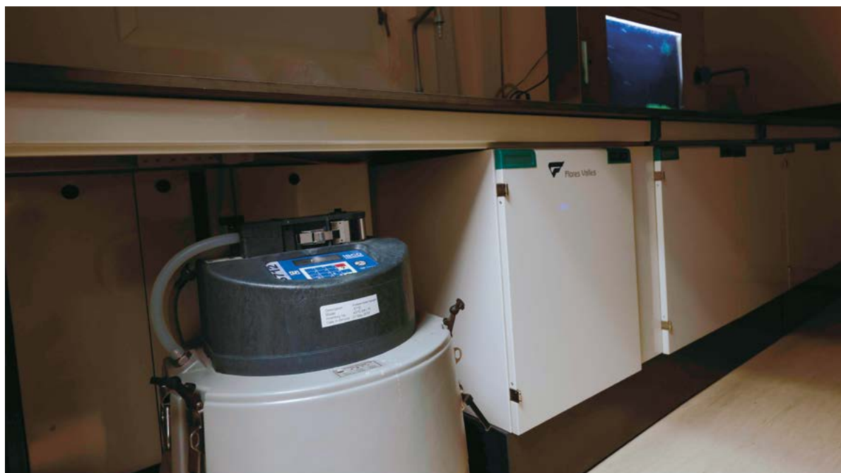
▲ 上水濾水廠是首個應用生物感應預警系統的濾水廠，當斑馬魚表現異常，預警系統便會發出警號，並自動即時抽取水樣本作化驗，圖中左下角為採樣器。
