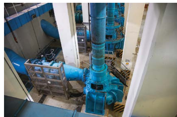
▲ 摩打推動平衡軸帶動水泵，將原水泵到水塘或濾水廠。
