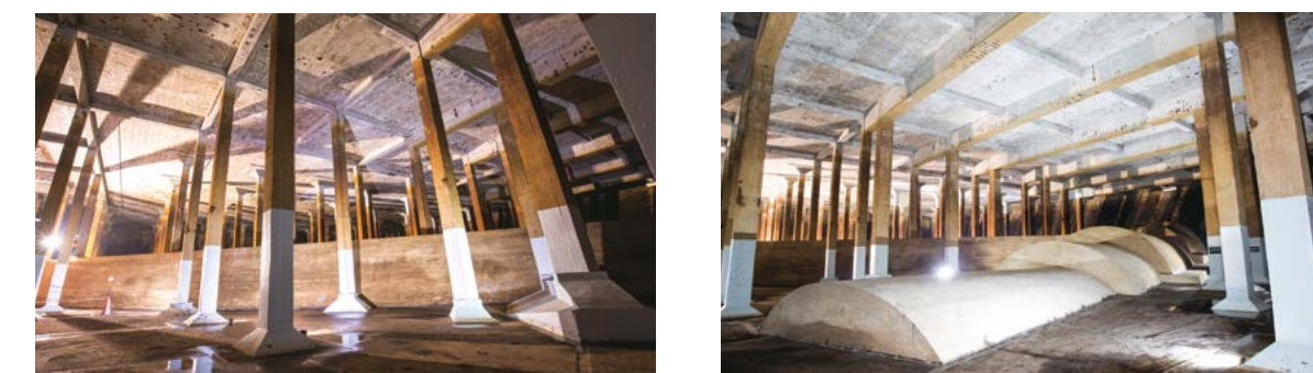
▲ 雅賓利配水庫排水後的內部情況
