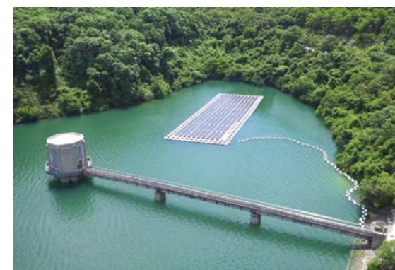
▲ 石壁水塘的浮動太陽能發電系統
