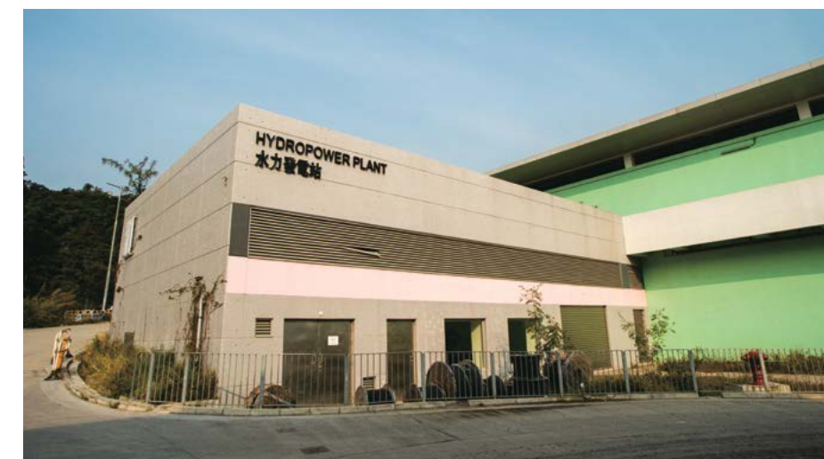
▲ 沙田濾水廠內的水力發電站
