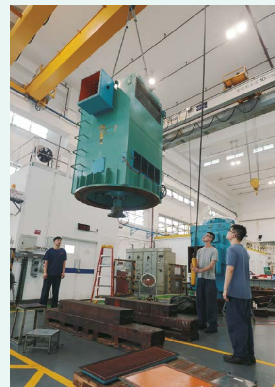
▲ 機電工場設有大型起重機，方便移動馬達。
