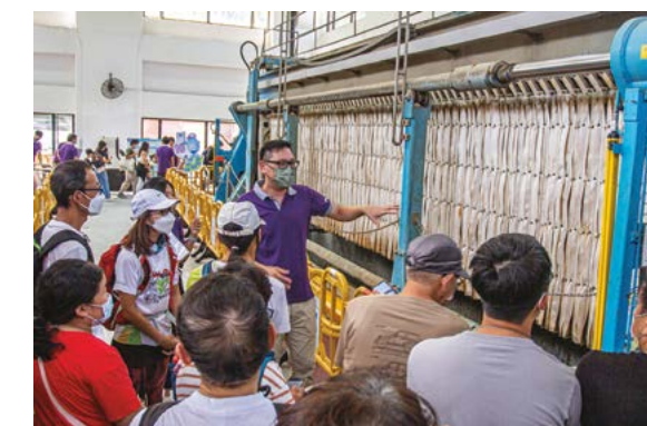
▲ 濾水廠開放日吸引大批市民參觀，相片攝於淤泥壓濾機機房。
