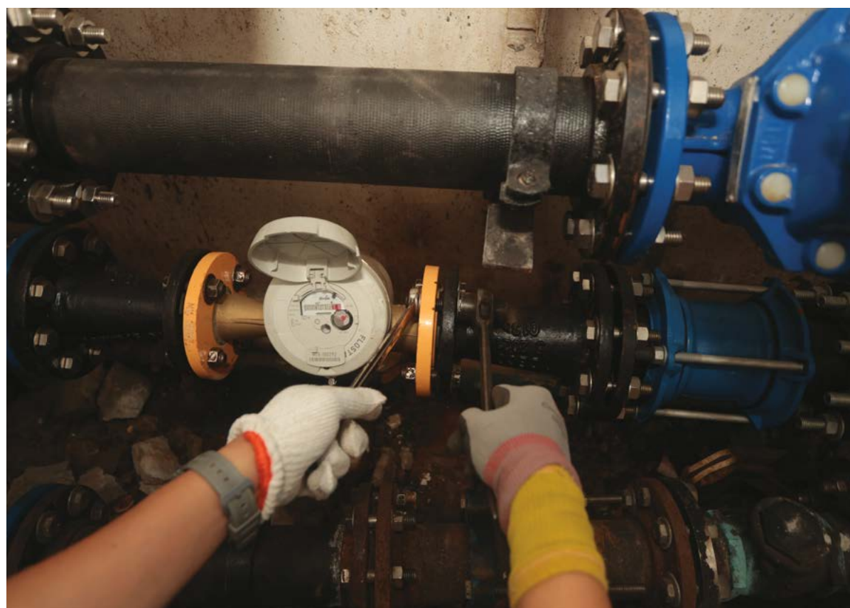
▲ 水務人員安裝水錶
