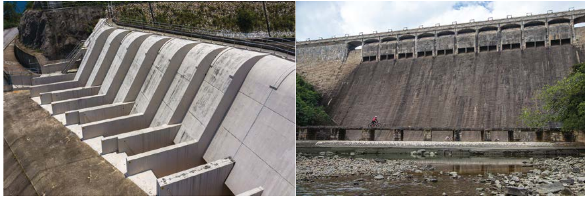
▲ 船灣淡水湖副壩（左）及大潭篤水壩（右）的溢洪道
