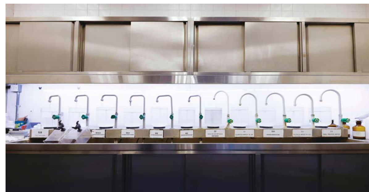
▲ 濾水廠控制室內設有多個樣本盛載瓶，操作人員會留意各濾水工序完成後傳送過來的水樣本情況。
