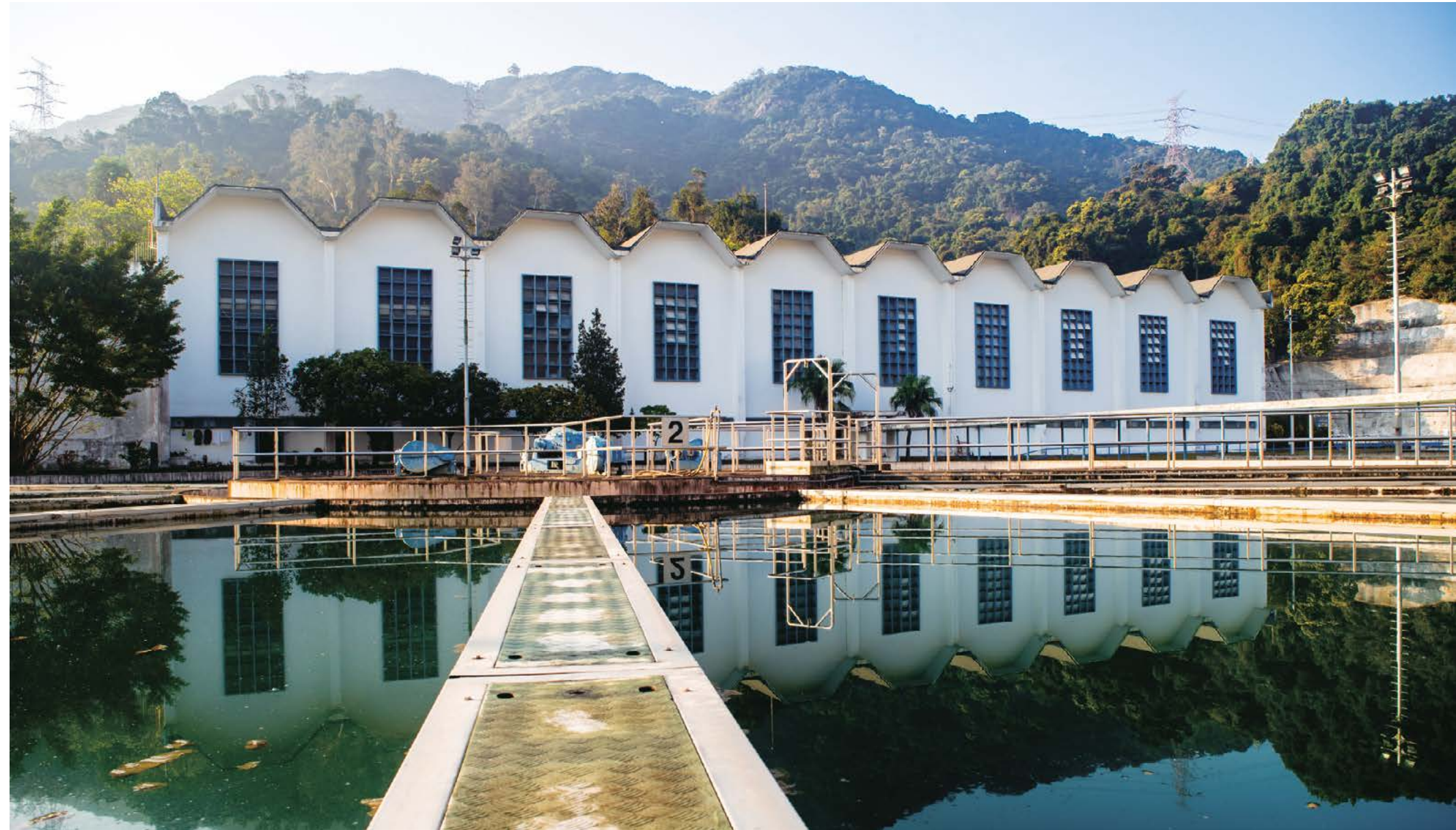
▲ 現已拆卸的化學房將會興建洗池水均衡池、絮凝及沉澱池，以及臭氧樓等。
