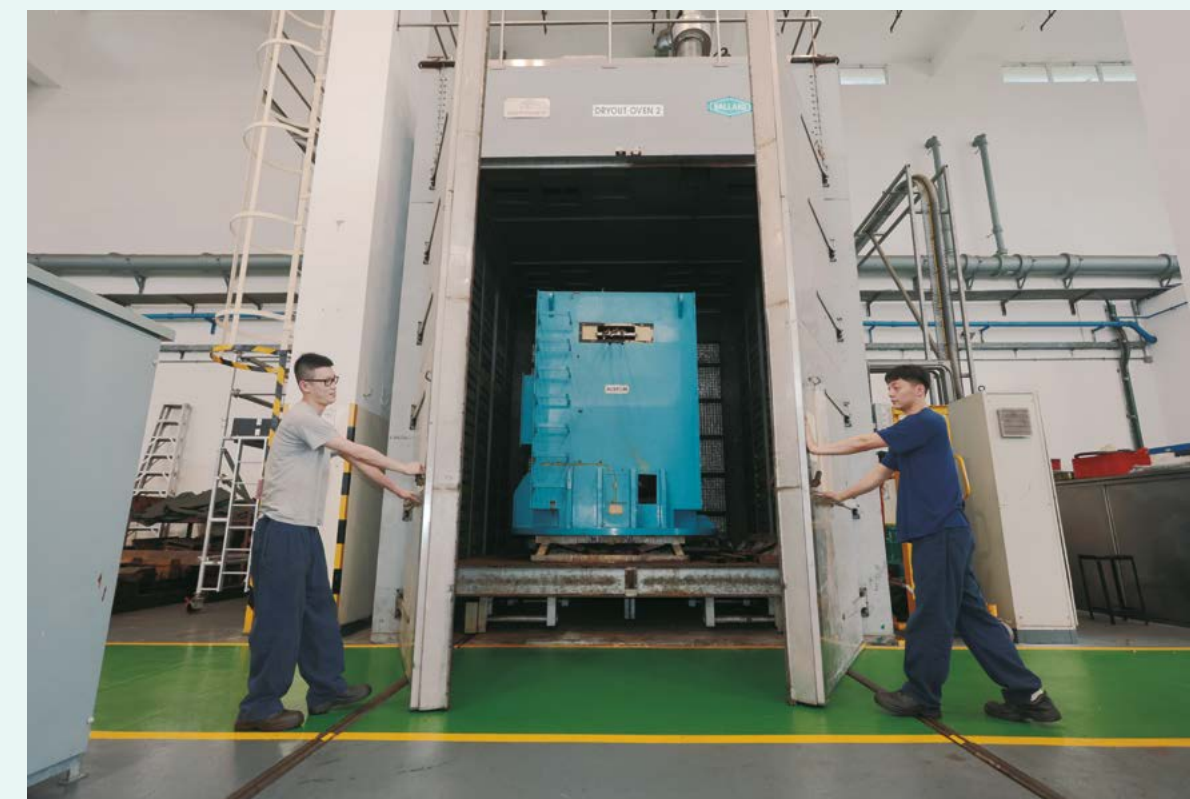
▲ 電機工場設有大型焗爐，將馬達內水分抽乾，確保其絕緣度。
