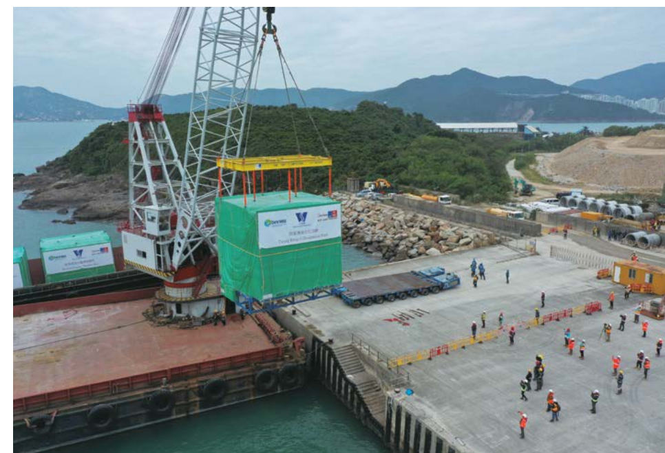
▲ 壓力容器組件抵達將軍澳海水化淡廠工地
