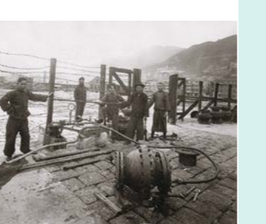
▲ 第一條海底輸水管於1930年建成
