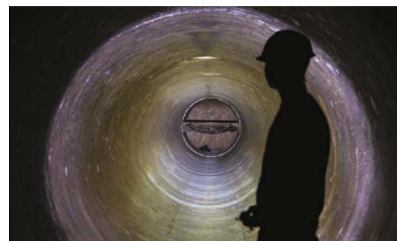
▲ 木湖原水抽水站於12月進行年度維修，工程人員會進行詳細檢查。
