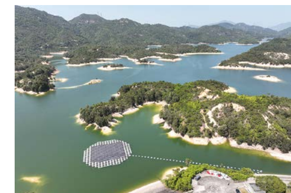
▲ 大欖涌水塘的浮動太陽能發電系統採用圓形設計
