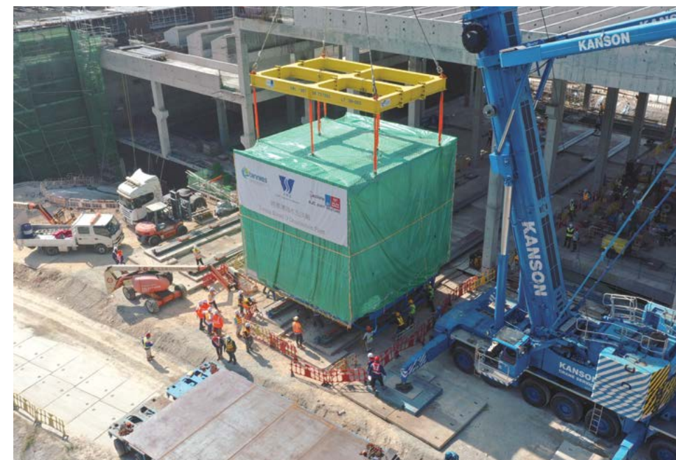
▲ 巨型起重機將重90噸的組件吊放至路軌
