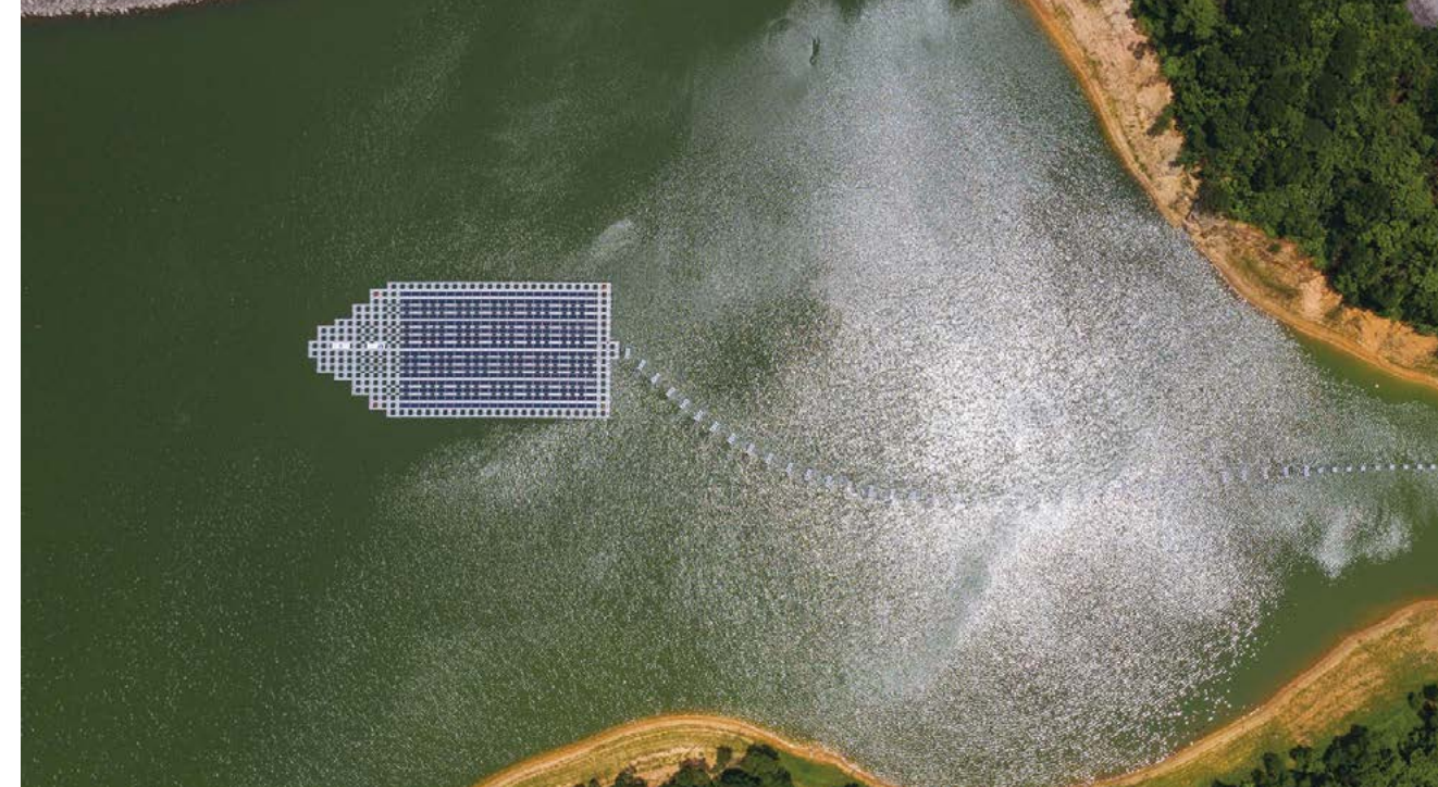
▲ 船灣淡水湖的浮動太陽能發電系統，其浮板排列如船形。
