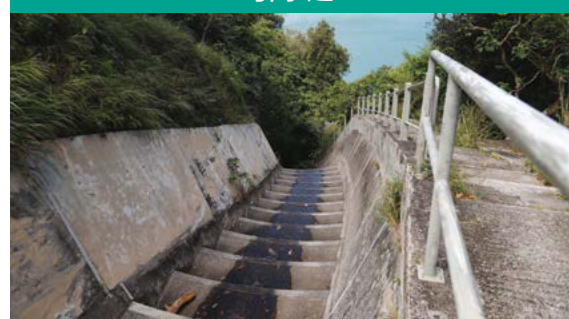
▲ 引水道將集水區內收集到的水引流向水塘
