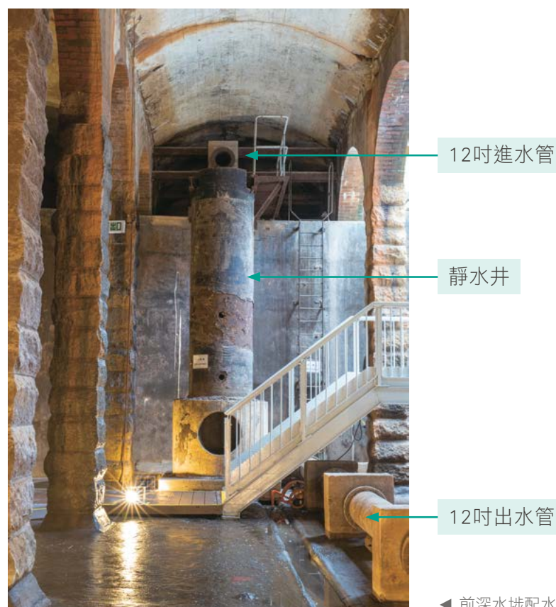
◀ 前深水埗配水庫內的靜水井、進水管及出水管。
