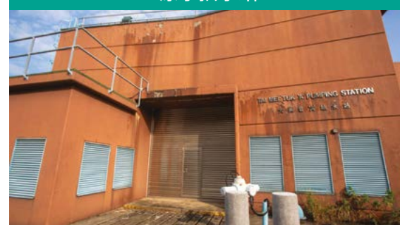
▲ 大美督原水抽水站
