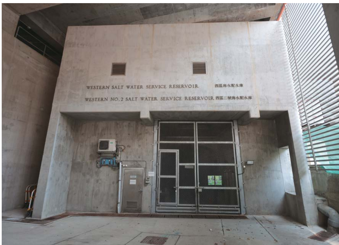
▲ 西區海水配水庫和西區二號海水配水庫的入口
