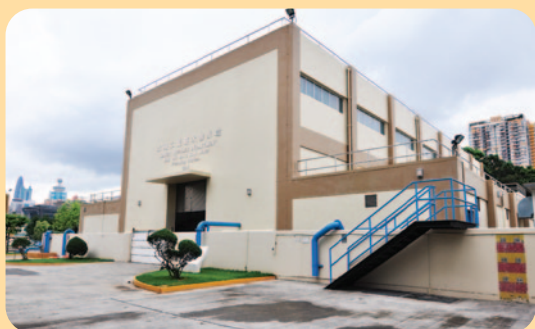
水湖2號原水抽水站現況
