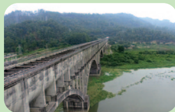
旗嶺渡槽外觀
