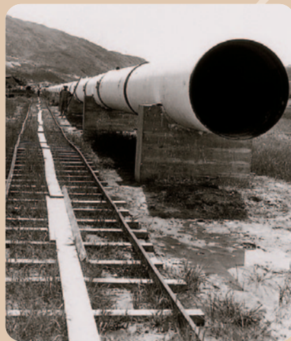
1960年鋪設直徑48吋的大型水管以接收深圳水庫的供水
