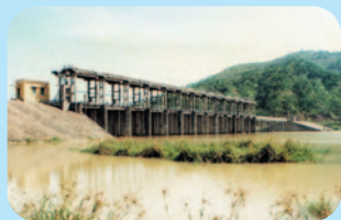
一期擴建工程 — 旗嶺閘壩
