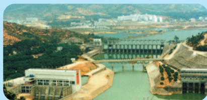
三期擴建工程後的馬潭抽水站全景
