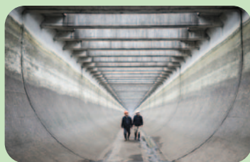
停水檢修期間的金湖渡槽內部
