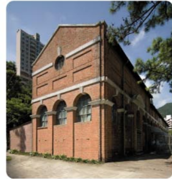
大潭篤原水抽水站 Tai Tam Tuk Raw Water Pumping Station
