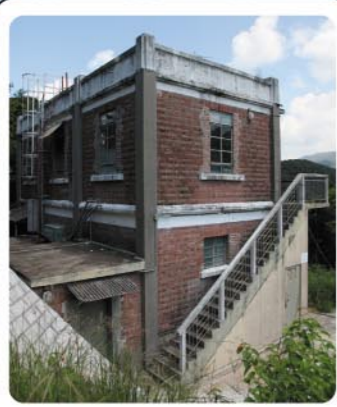
大潭篤原水抽水站二號 員工宿舍 Tai Tam Tuk Raw Water Pumping Station No.2 Staff Quarters
