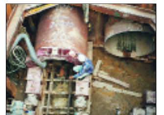
以推移方式敷設水管。 Pipe jacking work.
