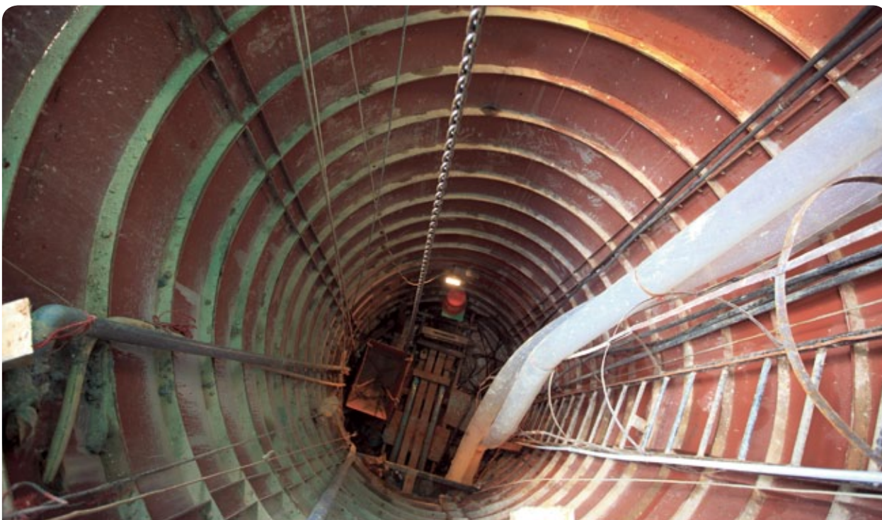
位於動植物公園的進口井，用以進行水管推頂工程。 A launching pit at Hong Kong Zoological and Botanical Gardens for pipe jacking.
