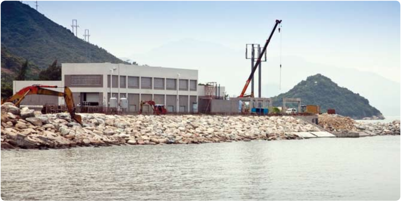
興建中的欣澳鹹水抽水站。 Sunny Bay Salt Water Pumping Station under construction.
