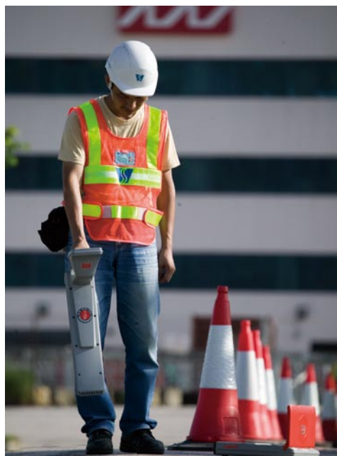
使用地下管探測儀。 Staff using pipe locator.
