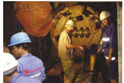
利用隧道鑽挖機敷設地下水管。 Making use of tunnel boring machine to lay water mains.
