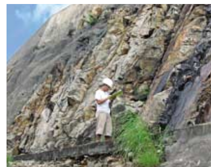
工作人員正進行斜坡安全檢查。 Staff carrying out slope safety inspection.
