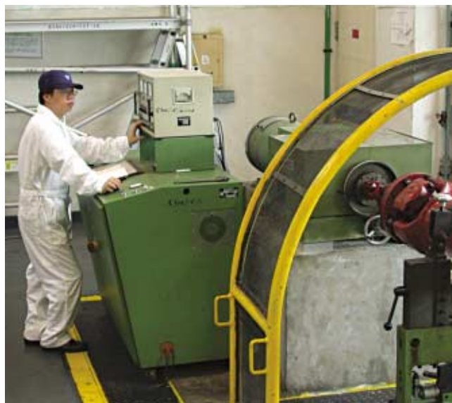
工作人員正為一個剛完成維修的電動機轉子作轉動平衡測試。 A repaired electric motor rotor being tested on a dynamic balancing machine.
