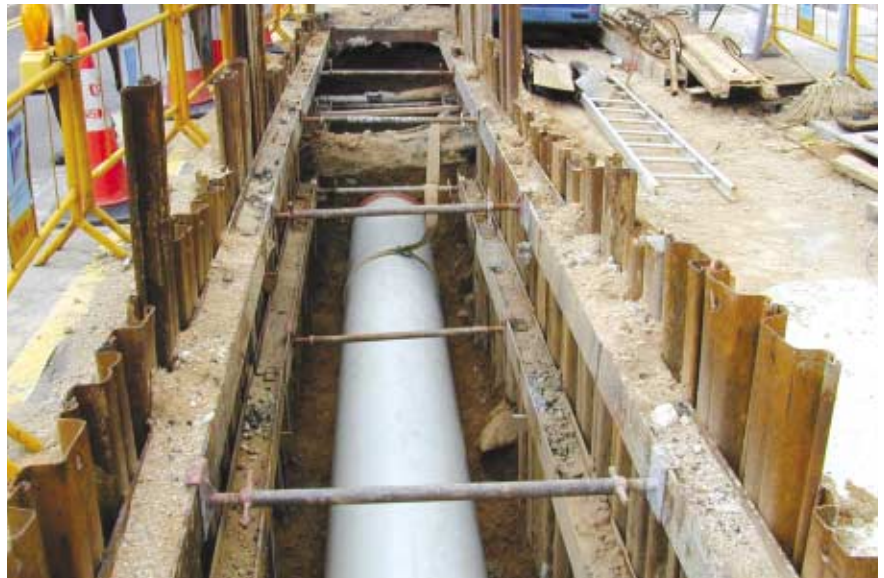
安裝地下水管工程進行中。 An underground water main being laid.
