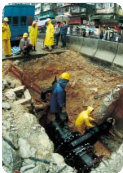
工作人員為剛修妥因爆裂而損壞的地下水管作最後檢查。 Staff making a final inspection on the repaired underground pipes after a mains burst.
