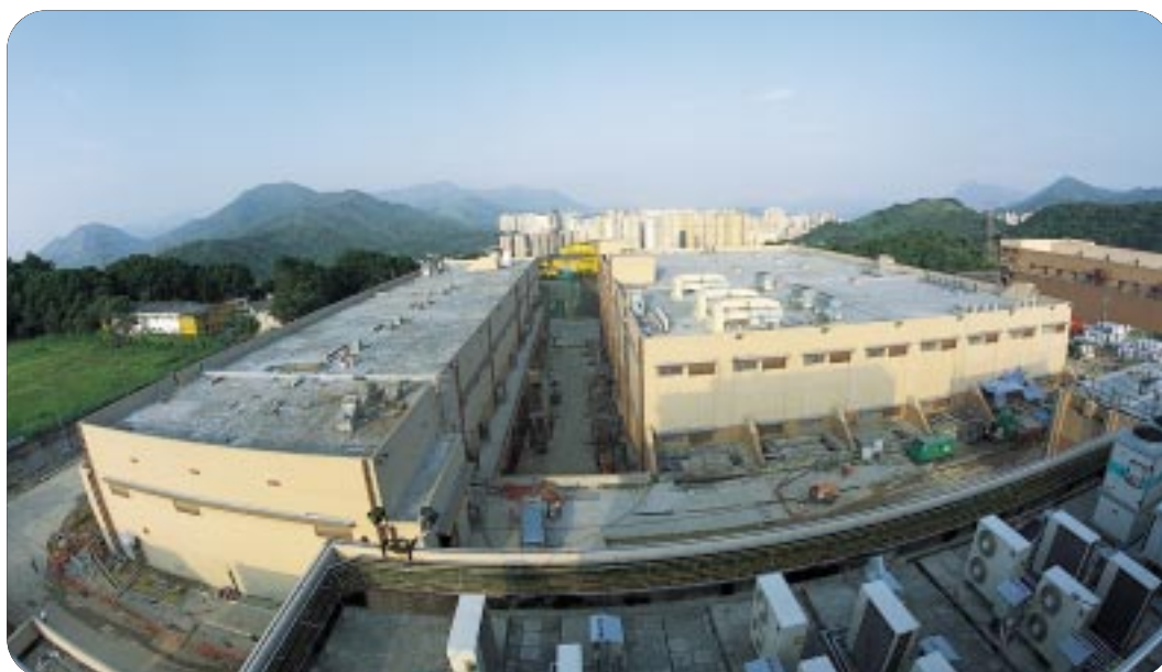
興建中的大埔濾水廠。 Tai Po Water Treatment Works under construction.
