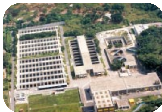
凹頭濾水廠。 Au Tau Water Treatment Works.
