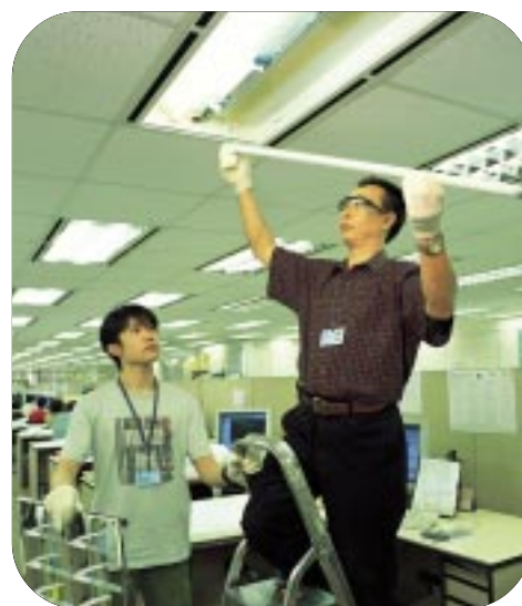
工作人員正安裝可提高能源效益的螢光管。 Staff installing the energy efficient fluorescent tubes.
