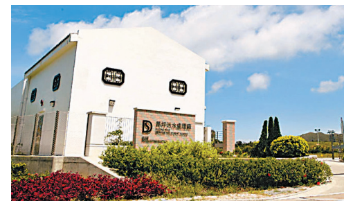
■昂坪污水處理廠
