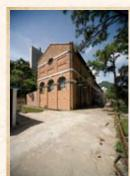
隧道進水口。當中的機器房是具歷史價值的罕有工業建築物。這座 倉庫式建築物以紅磚為牆,鋪有中式瓦片的屋頂將機器房覆蓋在內, **蔑器房理作最初的數十年仍装有**着 汽推動的抽水機,每日可輸送300萬
