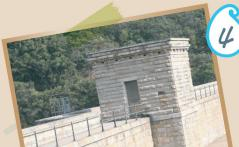
水掣房沿水壩頂部約三分之一位置興建,為一座簡單的方形構築物,只有一個門口,而小窗口現已封閉。 水掣房以層列石面粗琢花崗石築成。原來的廡殿式屋頂已由平屋頂取代,突出的飛檐由雕飾托臂承托,依
