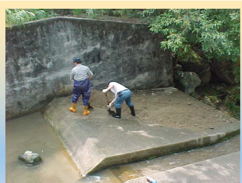
水文組同事正在清理V-notch口沙堆，避免外尺及V-notch口被遮掩。
