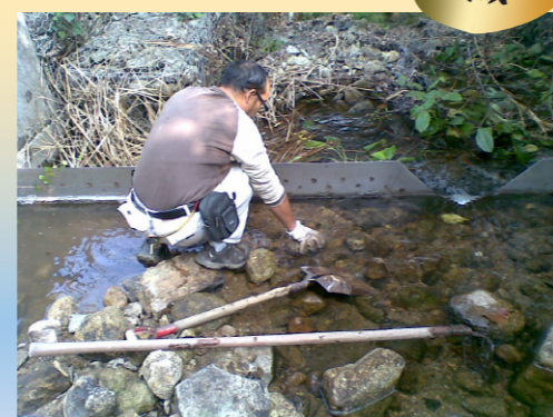
沙石已堆積到V-notch口，需要同事用手逐一清理。
