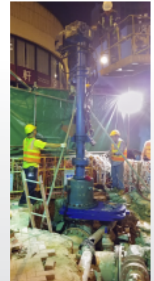
Hot-tapping 工序進行中
