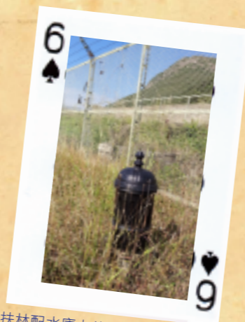
圖一：薄扶林配水庫上的通風口 (三級歷史建築)
