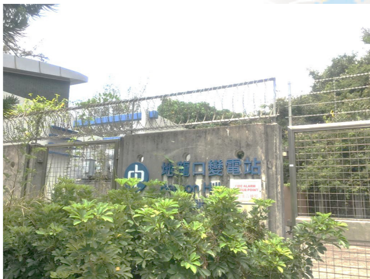
沙田濾水廠地龍口變電站門口
