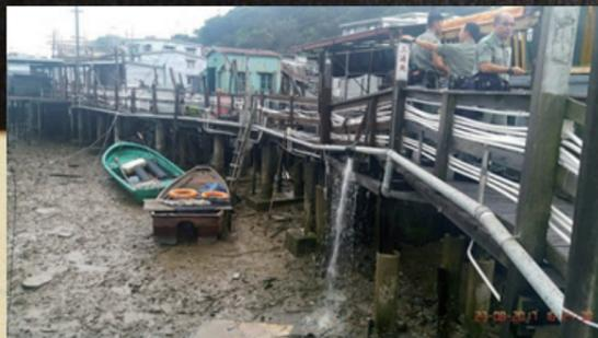
大澳三涌棚一條直徑80毫米外露喉管爆裂打響了搶修的頭炮
