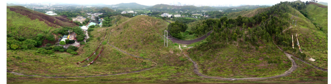
定期拍攝空中 360° 全景照片，用作監察工程進度
