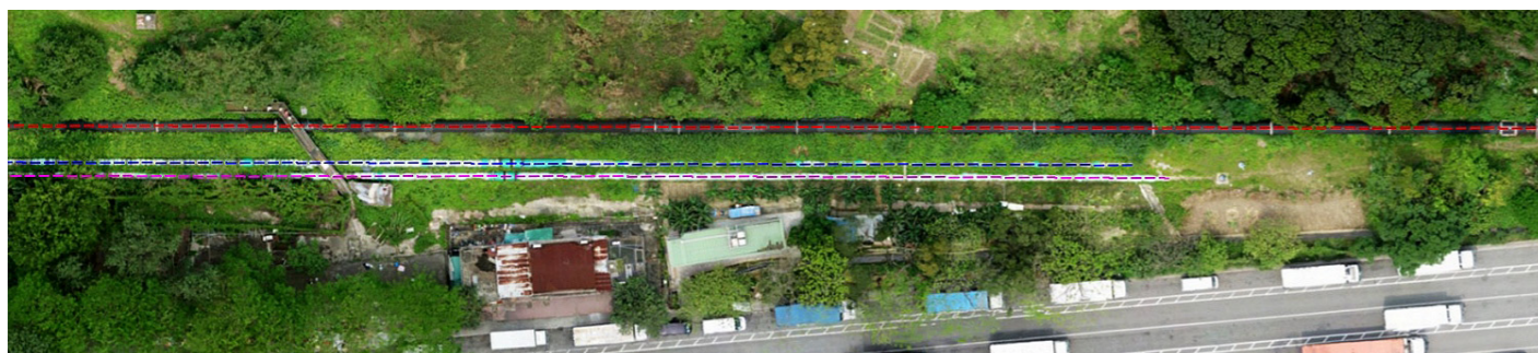
在2016年5月通過航拍，為部分東江水輸水管道建立準確的準線
