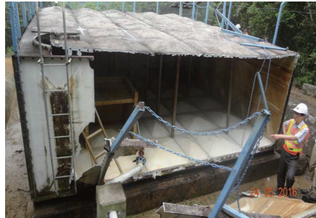
新界東高級工程師（三組）陳子浩（現為土木工程拓展署總工程師）當日到場視察爆水缸情況
