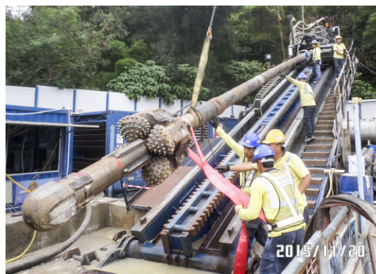
將直徑28吋的鑽機組群安裝在鑽機上進行擴孔工序
