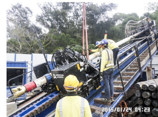
將直徑12吋的鑽機組群安裝在鑽機上進行導向孔鑽挖
