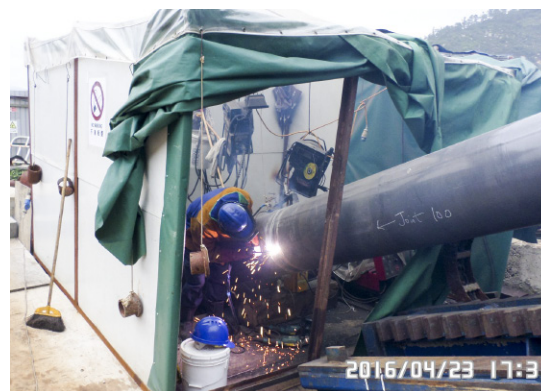
為新安裝的鋼喉進行焊接
