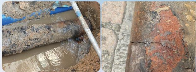
漏損管理組(九龍區)根據在渡船街設立的監測區域收集的數據，發現該監測區域的「最低晚間流量」偏高，於是聯同九龍區(分配1)跟進。經覆核後，確定漏水位置為文昌街200毫米食水供水管。在分區同事完成維修後，該監測區域整體最低晚間流量大降八成，失水情況明顯改善。
