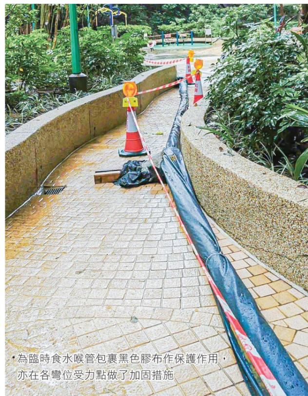
為臨時食水喉管包裹黑色膠布作保護作用,亦在各彎位受力點做了加固措施
