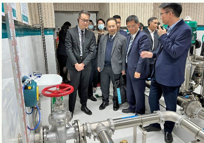
署長邱國鼎（左一）及助理署長/新界尤孝賢（左二）了解內部供水系統的改善工程
