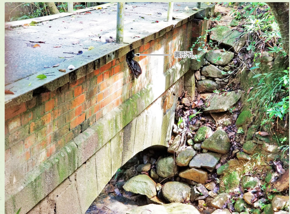
照片14：25號橋，向上游方向有圓形孔
