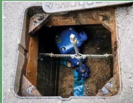
圖4：安裝雙氣閘DN150 DAV installation及造回路面
