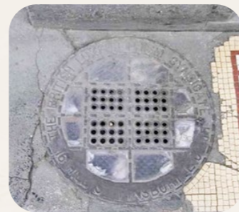
倫敦街道上現存的維多利亞時期天窗（圖片由Luxcrete公司提供）
