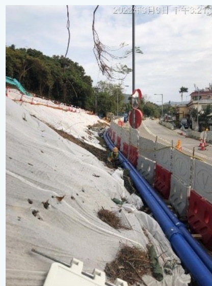
在落馬洲河套地區發展的相關工程地盤附近敷設明喉
