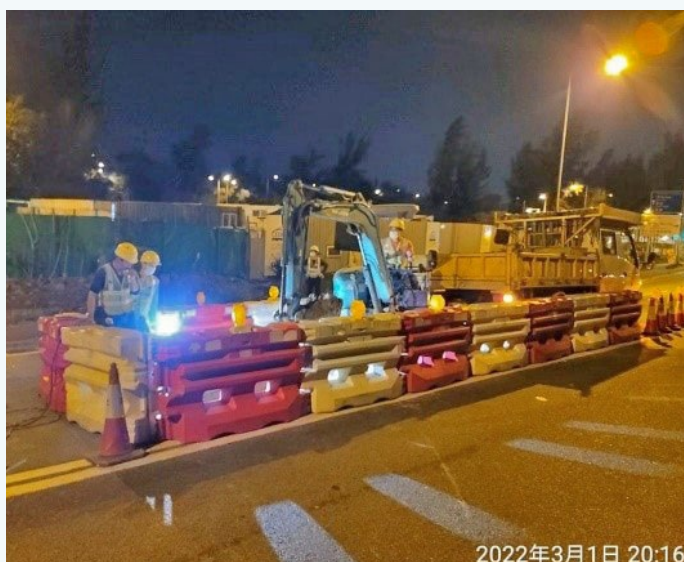
於青山公路——洲頭段進行緊急接駁工程
