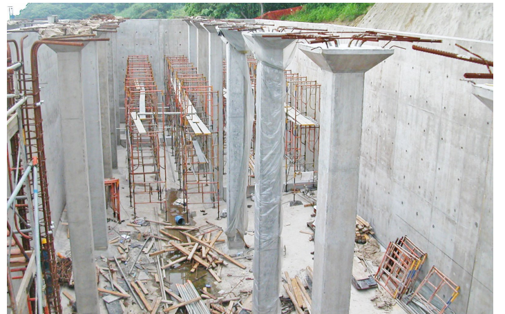
桌山二號食水配水庫採用石屎牆作支撐塘面設計（左圖），相比傳統以石屎柱支撐塘面更好（右圖），其好處之一，因為石屎牆高過最大容量的水位，所以水流控制和循環好一些，減少俗稱「死水」現象
