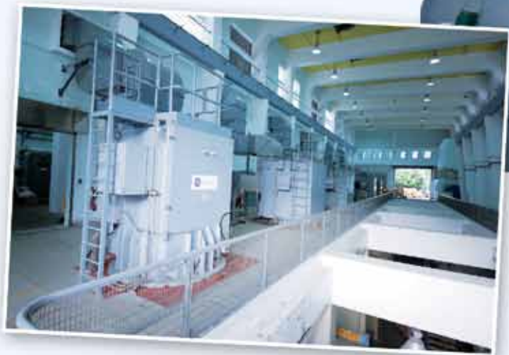
沙田濾水廠設置新泵
