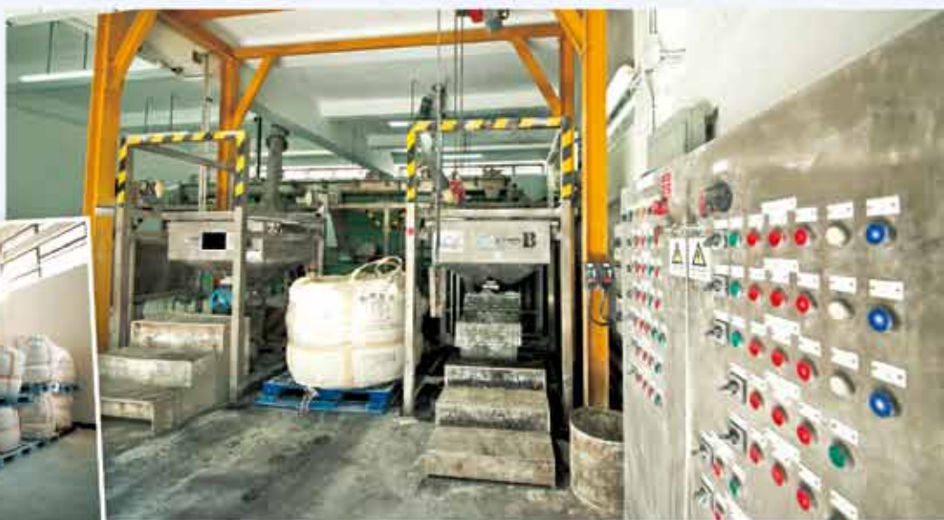
屯門濾水廠新設置使用特大包裝的石灰處理系統
