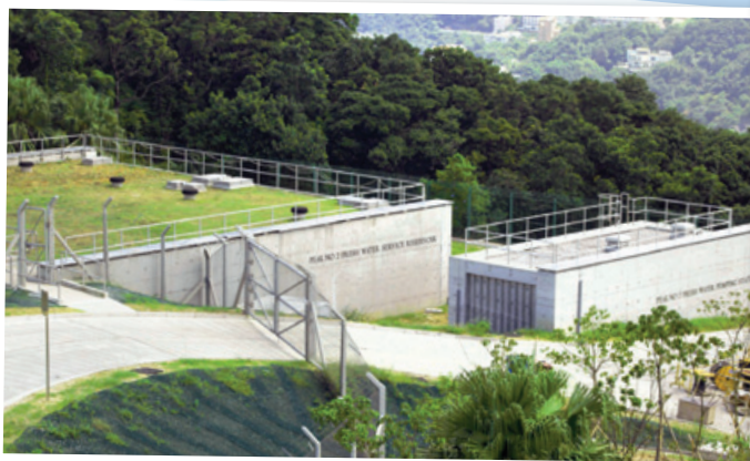
山頂二號食水配水庫於2011年底啟用。 Peak No.2 Fresh Water Service Reservoir commissioned in late 2011.
