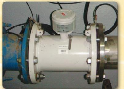
• 安裝在用戶水管上的電磁水錶。
