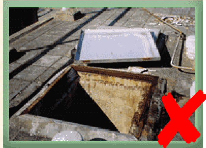
損壞、生鏽及沒有鎖的水箱蓋
