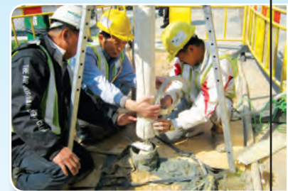
● 安裝鎂金屬陽極組件
