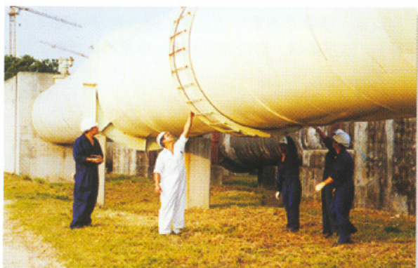
輸送廣東省供水的大口徑水管 (直徑 2.2 米及 2.4 米)
