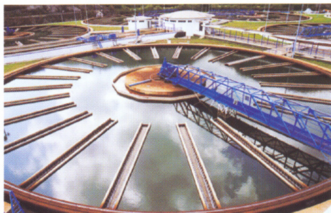
沙田濾水廠澄清池
