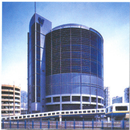
水務署九龍東區大樓
