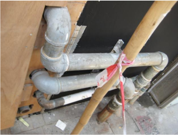
Photo 1. - DN50/Kembla/G/F Connection
