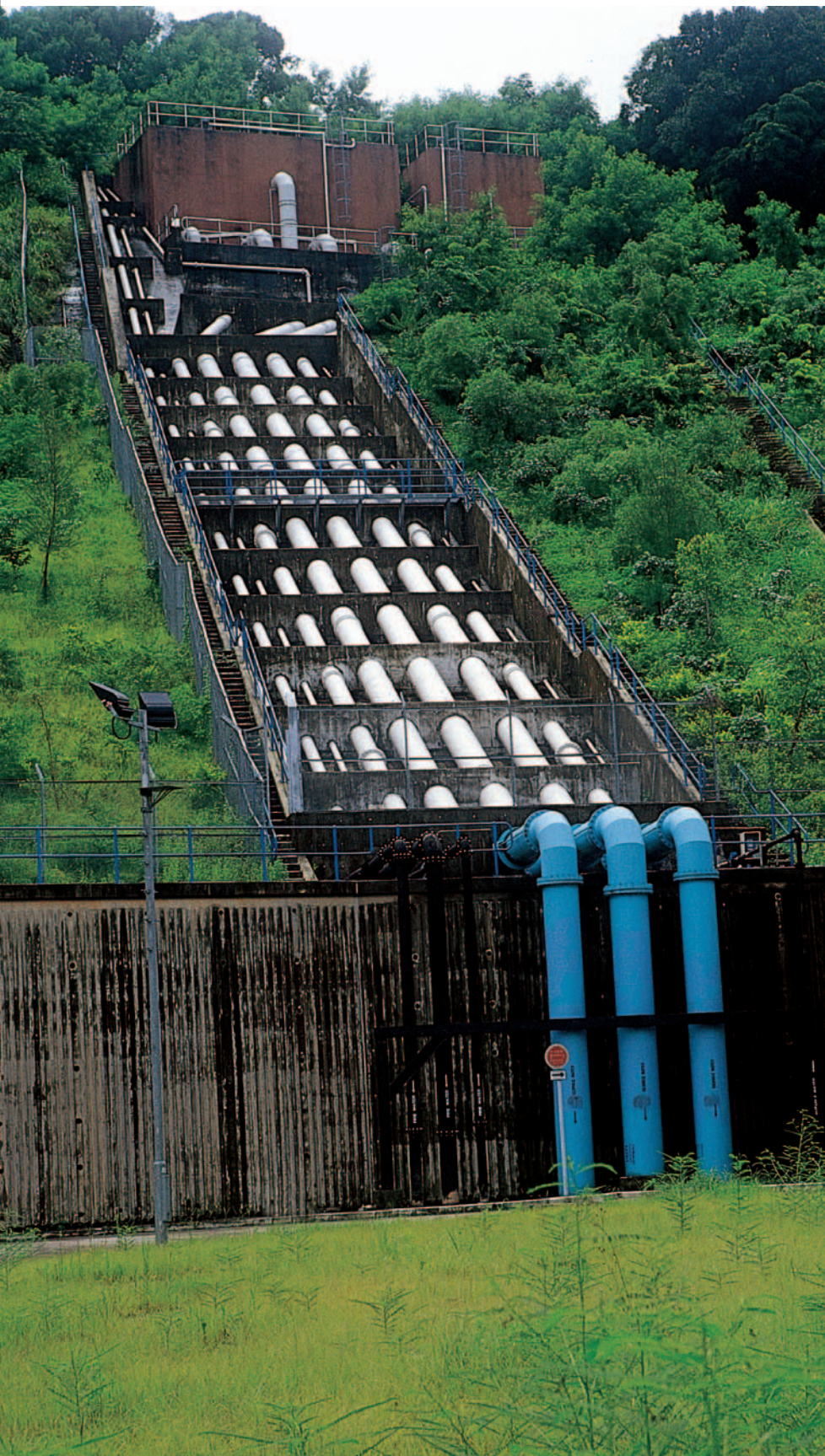
位於大埔濾水廠的出水管道。 Outlet water mains at Tai Po Water Treatment Works.
