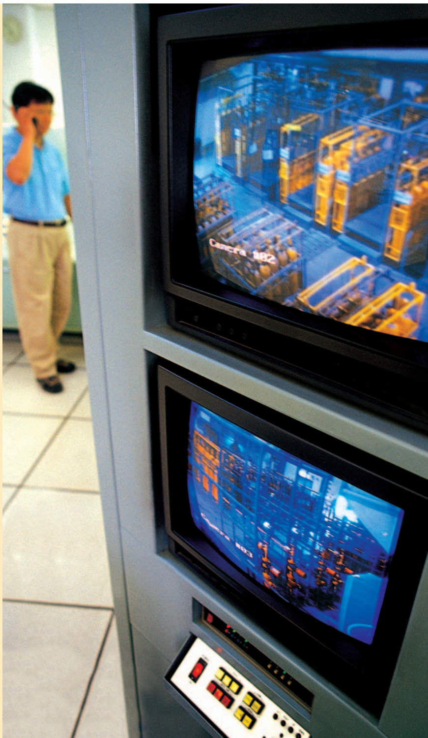
▲ 閉路電視是監察設備運作的有用工具。 CCTV is a useful tool for monitoring plant operation.
