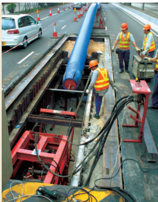
在吐露港公路上進行水管修復工程。 Performing mains rehabilitation work in Tolo Highway.
