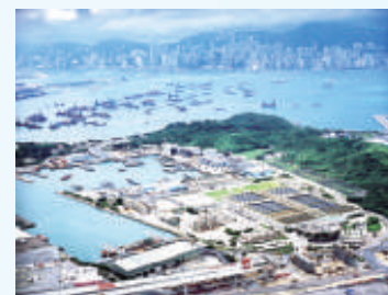
▲昂船洲污水處理廠
