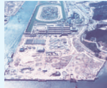
▲1982年啓用之沙田污水處理廠
