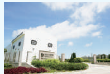
▲昂坪污水處理廠
