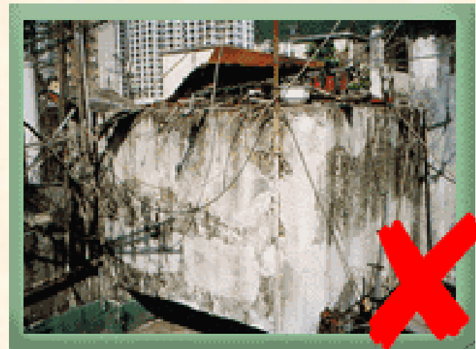
欠缺妥善維修、保養及管理的水箱
