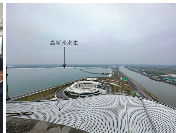
於高新沙調壓塔眺望新建的高新沙水庫
