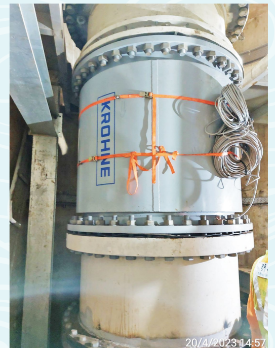
全新安裝的DN1600流量計
