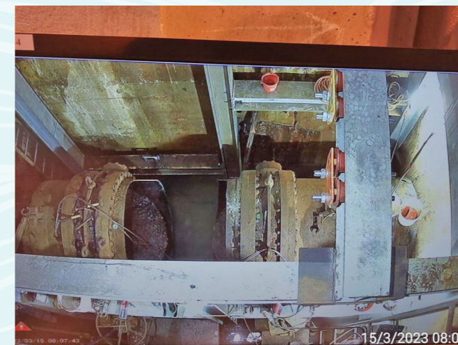
實時監控塔底工程狀況
