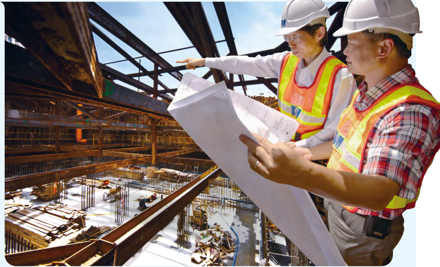
施工中的鋼線灣海水抽水站。 The Telegraph Bay Salt Water Pumping Station under construction.
